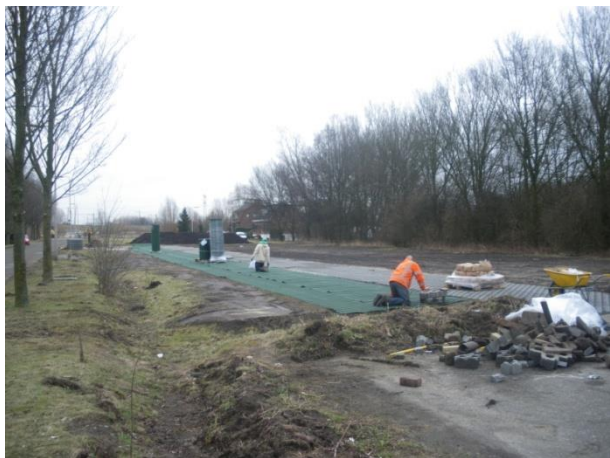
Start aanleg 1e gedeelte: "overloopparkerplaats" met middenpad in 'grasbeton' t.b.v. brandweer.
