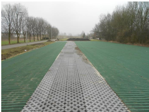
Start aanleg 1e gedeelte: "overloopparkerplaats" met middenpad in 'grasbeton' t.b.v. brandweer.
